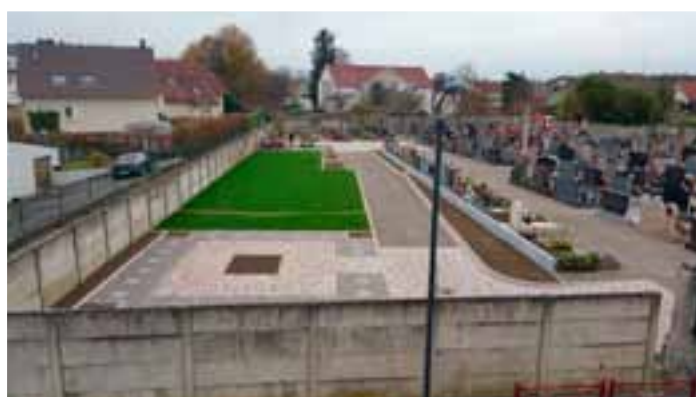
D'importants travaux au cimetière : arasement d'un mur, démolition de la morgue, création d'un ossuaire avec emplacement cinéraire et aménagement d'un parc paysager
