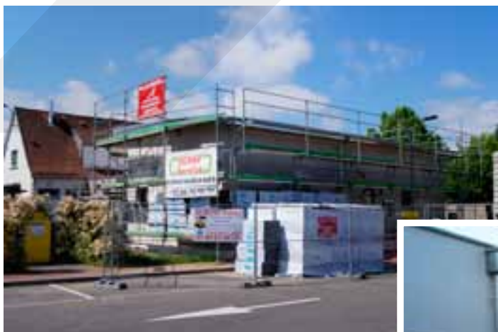
Travaux extérieurs en mai 2016
