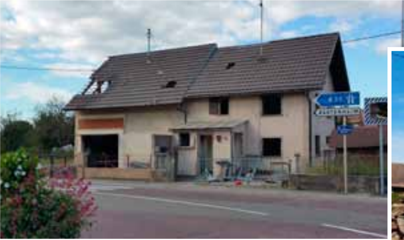
Démolition de deux maisons à l'angle de la rue de Kembs et de Bartenheim
