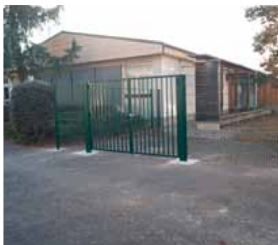
Rehausse de la clôture et des portails d'entrée aux écoles
