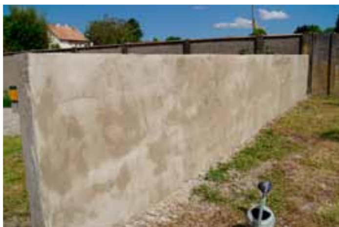
Travaux de maçonnerie réalisés lors de la Journée Citoyenne
