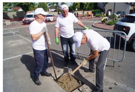
Implantation d'une arche de « stationnement réservé » Place du Général de Gaulle
