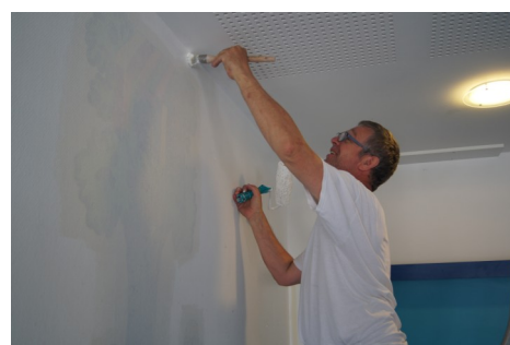
Travaux de peinture dans deux pièces du centre d'accueil Périscolaire
